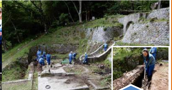
堆積土の撤去作業。泥にまみれて女性職員も頑張ってくれました
