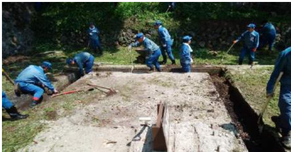
コンクリート面の表しとU字溝の泥の欠きだし搬出です。
